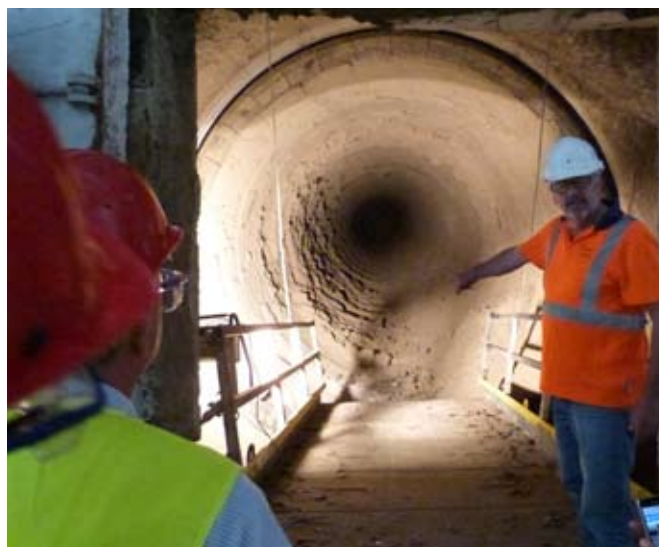
Blick in den Brennofen, Bernd-Henning Reupke erläutert die Funktion des Brennofens.
